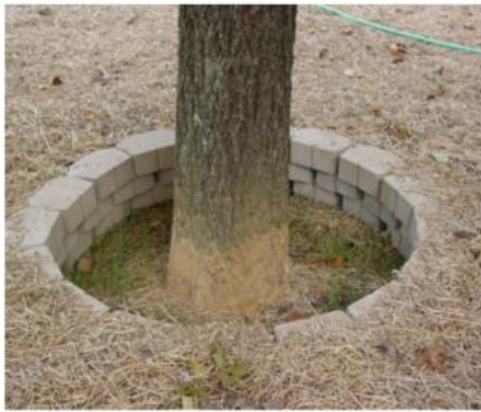
Giải pháp khi phải tăng cao độ đất nền xung quanh cây
