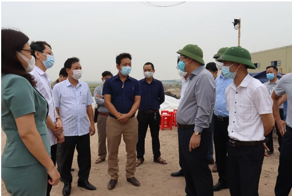
Đồng chí Bí thư Tỉnh ủy cùng đoàn công tác kiểm tra tiến độ thi công tuyến đường bộ ven biển đoạn qua xã Giao Yên huyện Giao Thủy
