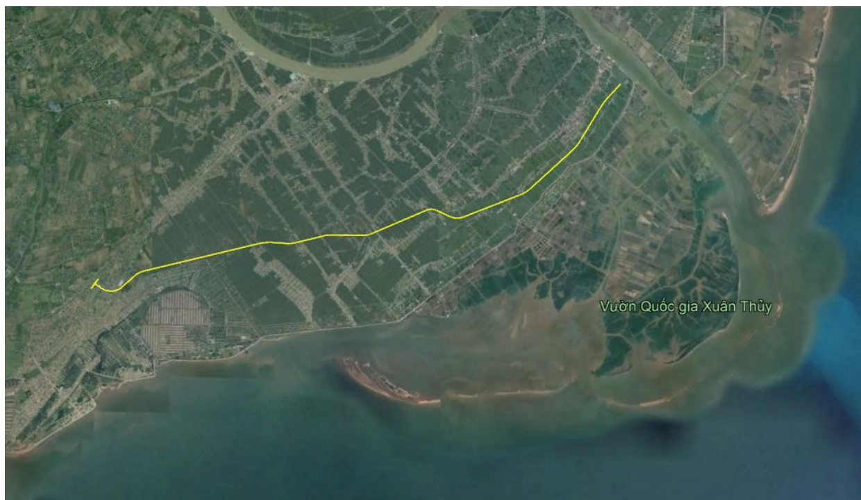
Hình 91. Tuyến đường bộ ven biển qua địa phận huyện Giao Thủy
