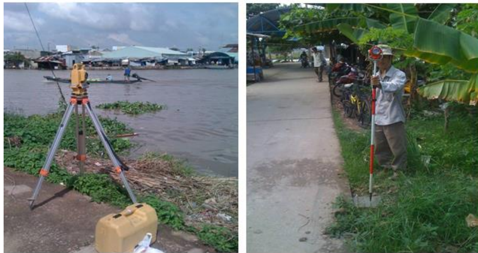
Đo chi tiết bằng máy toàn đạc điện tử
